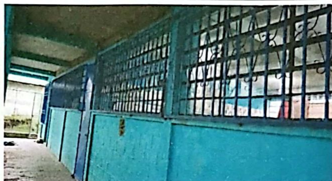
Foto 2: Instalacion de vidrios y balcones
